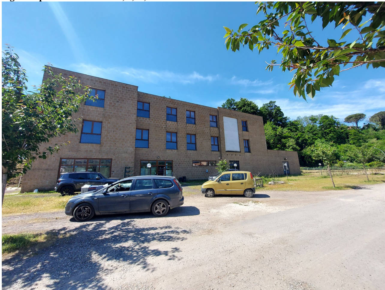
LOTTO N. 2 foglio 26 part.IIa 1034 – sub 8, 9,10,11 in corso di costruzione
